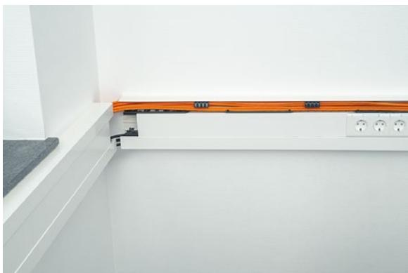
Durch die Ausschreibung und den Einsatz des Systems tehalit.BRN65 werden die Vorgaben der Norm zur Installation von Kommunikationsverkabelung strikt eingehalten. Schon durch die getrennte Verlegung in einem System und den richtigen Abstand von Energie- und Signalleitungen entsteht außerdem eine hohe Sicherheit für die Verfügbarkeit der Datennetzwerke.
