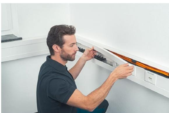
Durch die abnehmbaren Seitenoberseiten und die integrierte Trennung von Energie- und Datenleitungen durch das 3-Kammer-System hat der Planer Flexibilität fast bis zur letzten Minute. Die Nachinstallation ist möglich, ohne den laufenden Betrieb zu stören. Das empfiehlt den tehalit.BRN65 für die Anwendungsbereiche Office und IT-Infrastruktur.
