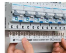
Dank den einseitigen Bi Connect Klemmen wird die Phasenschiene nur noch gesteckt.
