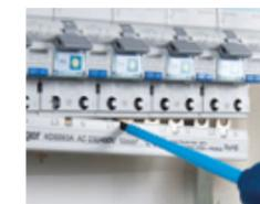
Einfache Demontage der Phasenschiene durch eine Hebelbewegung mittels Schraubenzieher.
