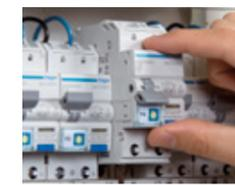
Offener Quick-Snap Schieber ermöglicht eine einfache Produktentnahme.
