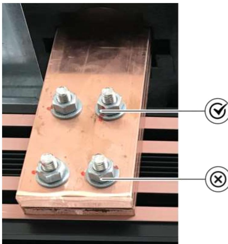
N.B. : les boulons sont destinés à un usage unique. En cas de démontage d'un ensemble ayant été serré au couple recommandé, l'ensemble des écrous, des boulons et des rondelles doivent être remplacés.
