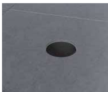
Τώρα μπορεί να τοποθετηθεί η τελική επίστρωση του δαπέδου
