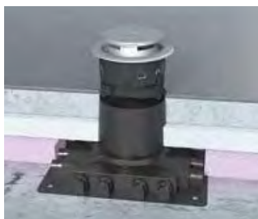
Τοποθέτηση σε δάπεδο από μπετόν
