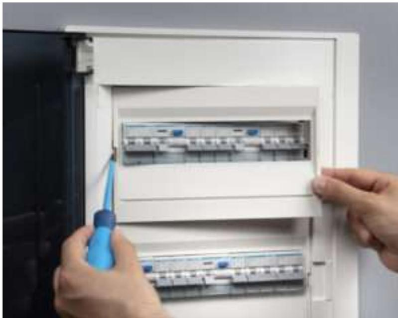
I PANNELLI estraibili consentono all'installatore di intervenire dove occorre, senza ulteriori smontaggi, in caso di manutenzione
