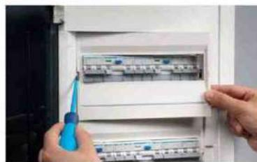
fissaggio, dotate di un sistema di ancore e con chiusura a un quarto di giro. Un altro valido supporto è fornito dalle prefratture presenti lungo le scatole che facilitano l'inserimento dei tubi corrugati. Inoltre, l'aggancio delle fascette di cablaggio è agevolato dai numerosi punti di fissaggio presenti nei telai dei centralini, che consentono di realizzare un lavoro ordinato e pulito. L'installa-
