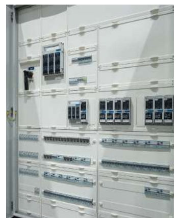
Hala logistyczna, Łódź
