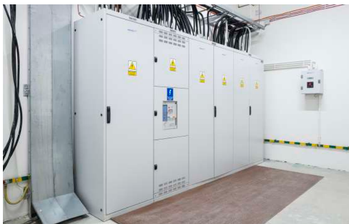
Hala logistyczna, Łódź
