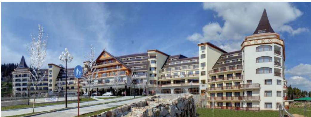
Hotel Gołębiewski, Karpacz Rozdzielnice główne na prąd znamionowy 2500 A z zaawansowanym układem automatyki SZR i sterowania zdalnego.
