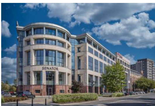
Biurowiec Senator, Warszawa Rozdzielnica główna na prąd znamionowy 2500 A i pomocnicze na 1600 A.
