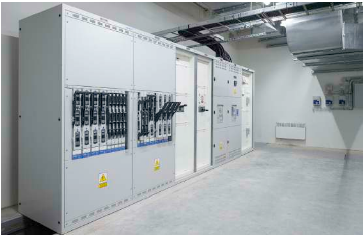
Hala logistyczna, Kołbaskowo
