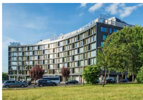
Green Horizon, Łódź Rozdzielnica główna na prąd znamionowy 3200 A.
