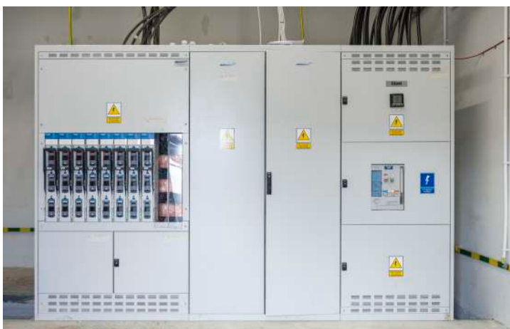
Hala logistyczna, Bielany Wrocławskie
