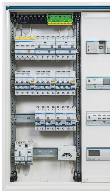
02 Montaż urządzeń zabezpieczających
