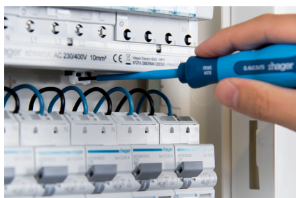
Odczepianie urządzeń przy pomocy zatrzasku Quick-Snap.
