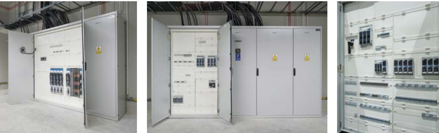
Hala logistyczna, Łódź
