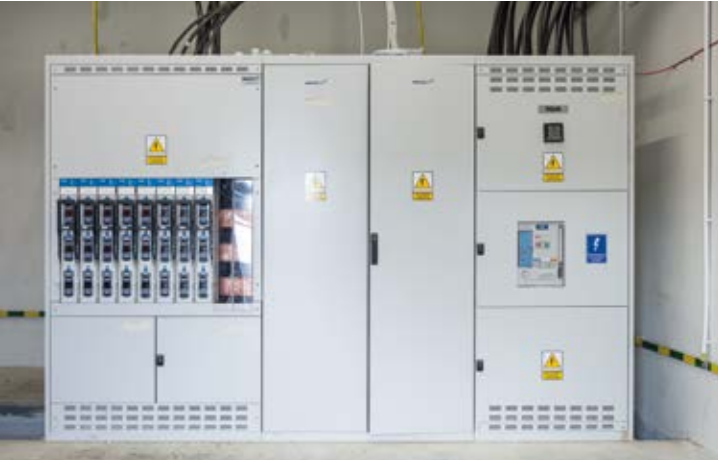
Hala logistyczna, Bielany Wrocławskie
