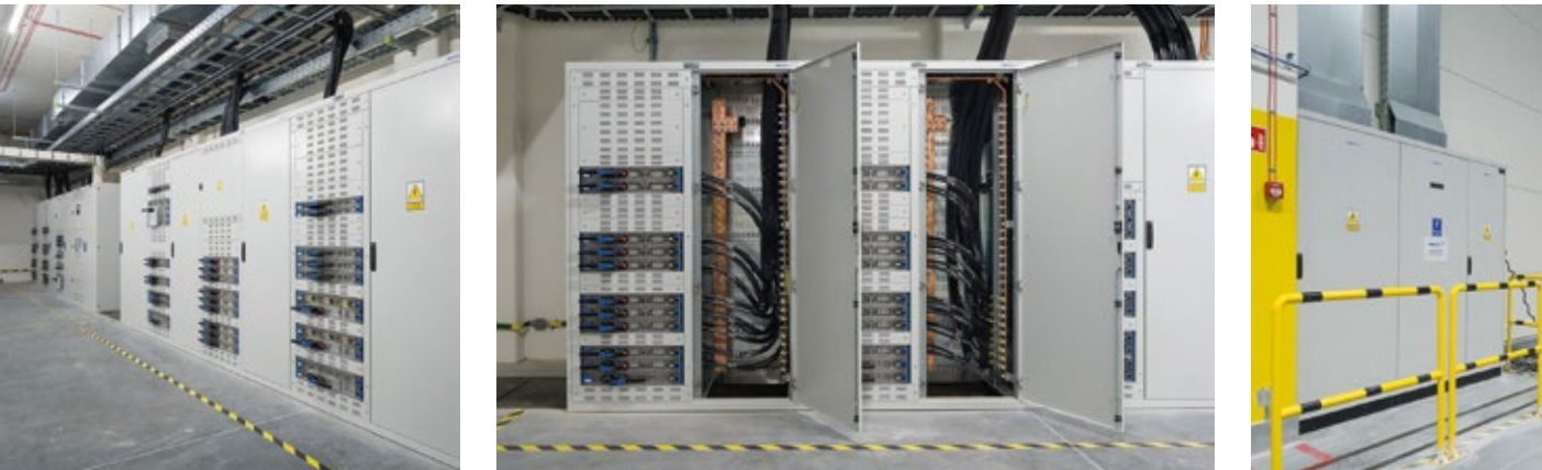
Hala logistyczna, Pawlikowice
