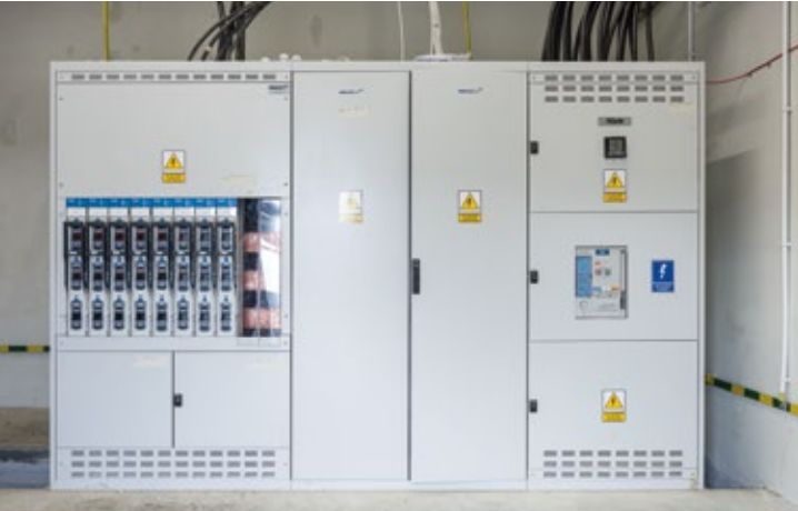
Hala logistyczna, Bielany Wrocławskie
