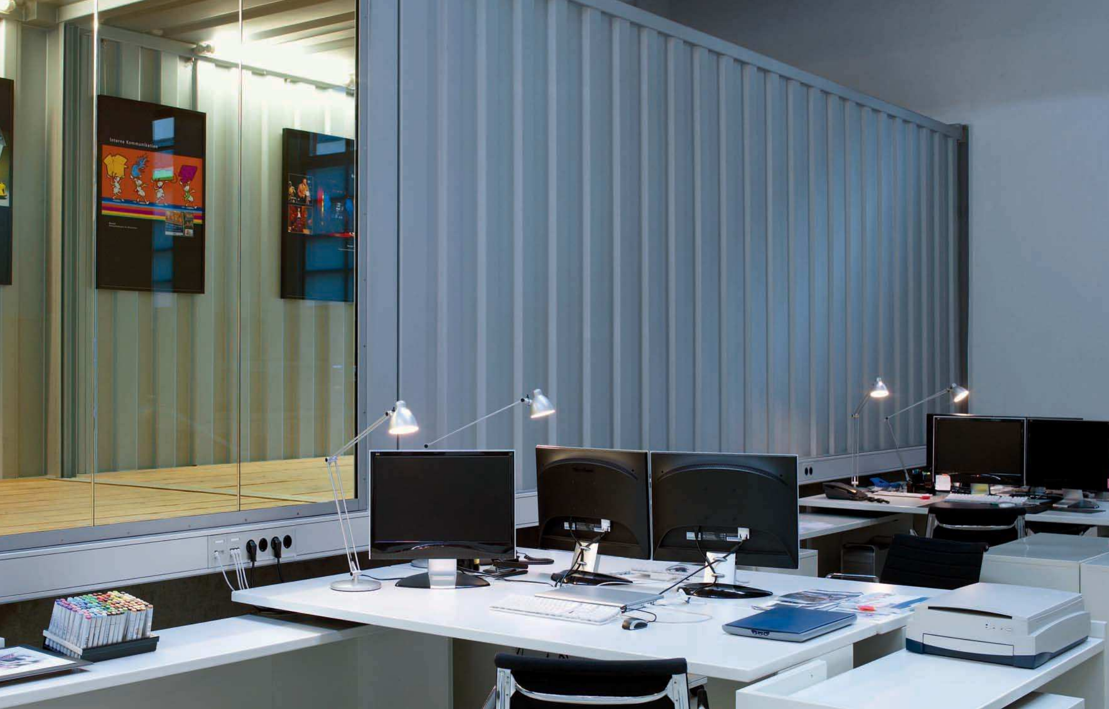
Integration eines Brüstungskanals BR in die Rauminstallation: Einbaugeräte für Energie und Daten exakt an der richtigen Stelle platziert.
