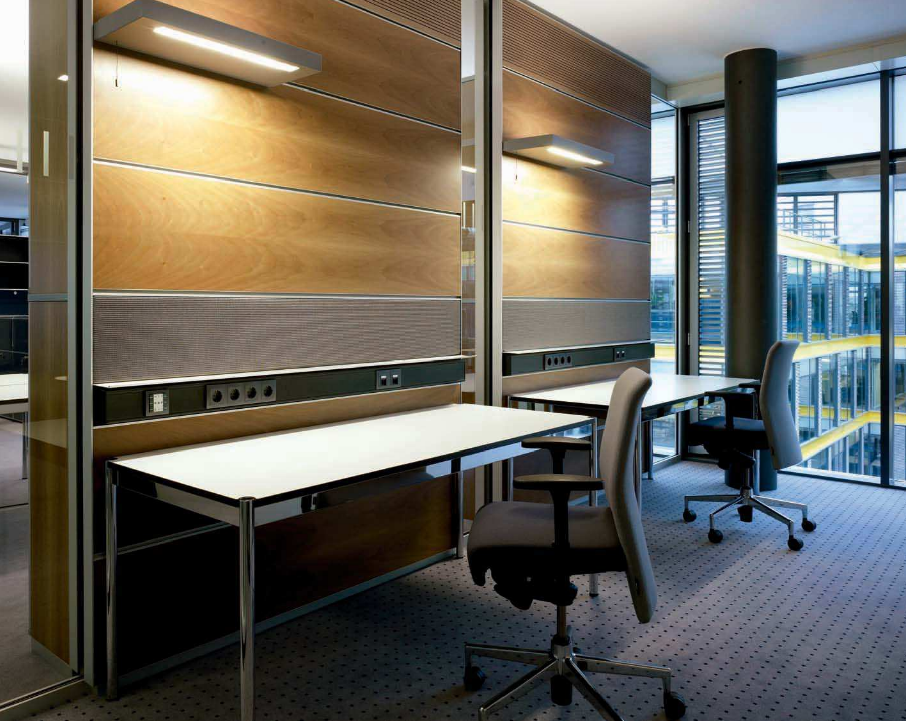
Büreeinheiten mit über den Arbeitstischen montiertem Brüstungskanal BR in anthrazit, dazu die passenden Energie- und Datenanschlüsse aus dem kallysto® Schalterprogramm.
