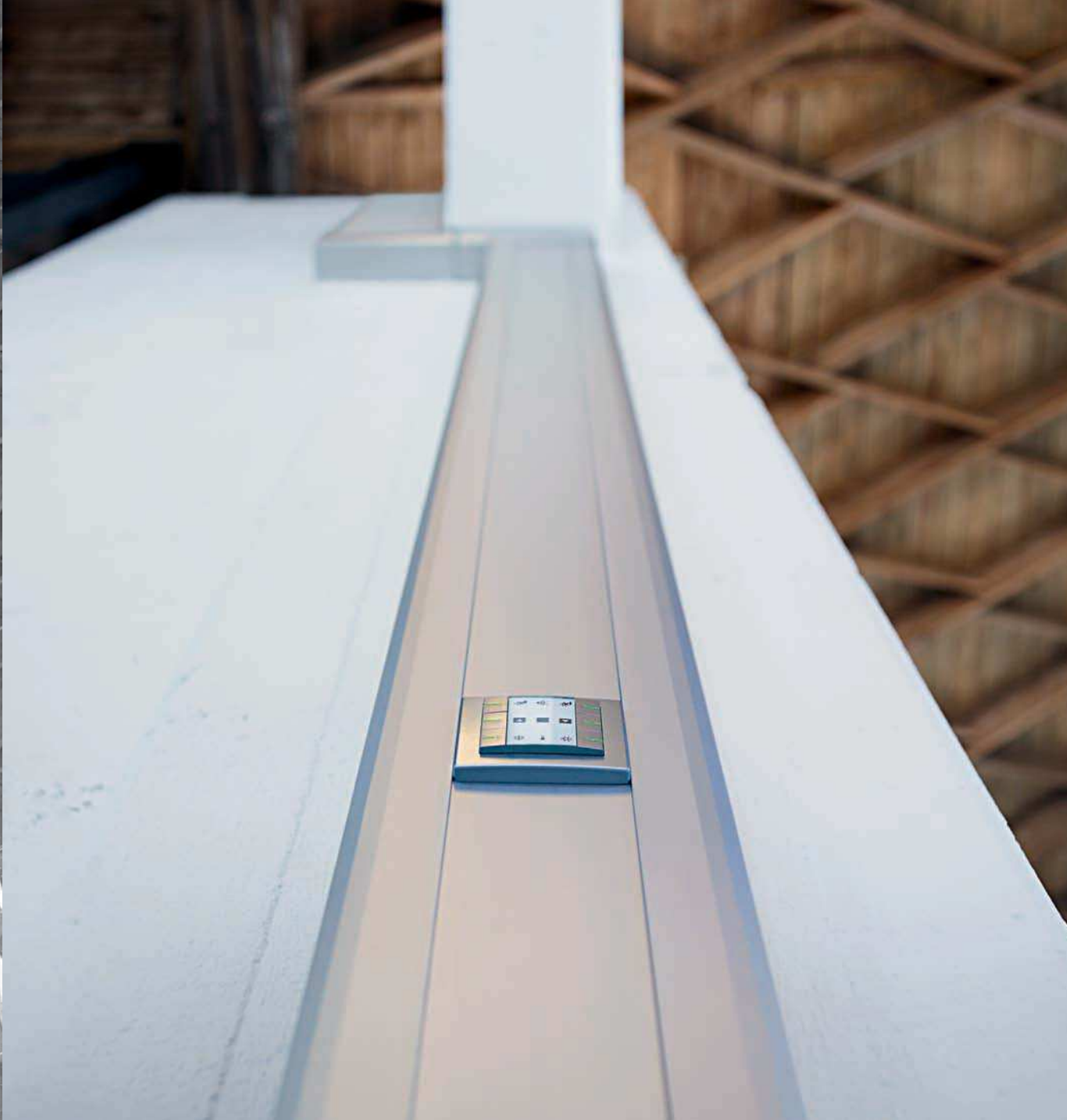
Senkrecht an der Säule angebaute Brüstungskanal BR netway® mit KNX-Taster aus dem kallysto® Programm.
