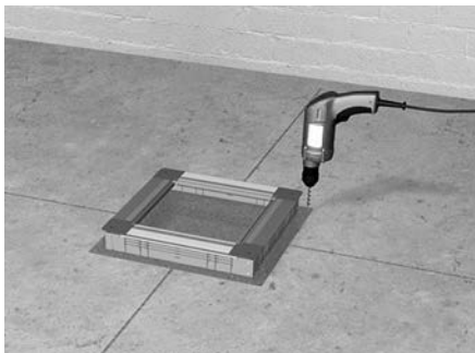
Fijar la caja al suelo. Asegurarse que la membrana está en el lado exterior de la caja.
